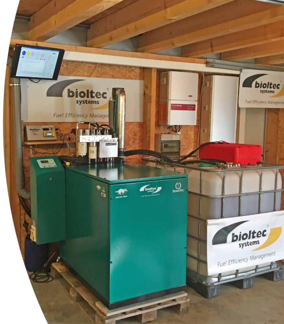
Figura 21: bioltec genny, Planta de demostración de cogeneración 5,5 kWel (combustible: grasa de pollo) y planta fotovoltaica 30 kWp con un sistema de almacenamiento en batería 10 kWh
